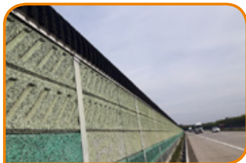
Zajvédő fal hatékonyságának növelése – elnyelő „cső” a fal felső élén (M0-ás autópálya)
