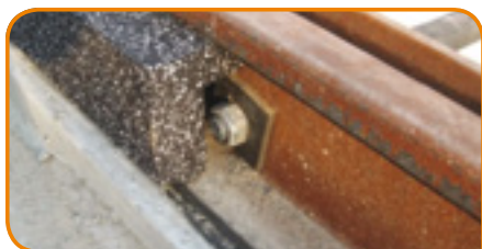
Villamos pálya rezgésszigetelt kialakítása (Budapest, Kossuth tér)
