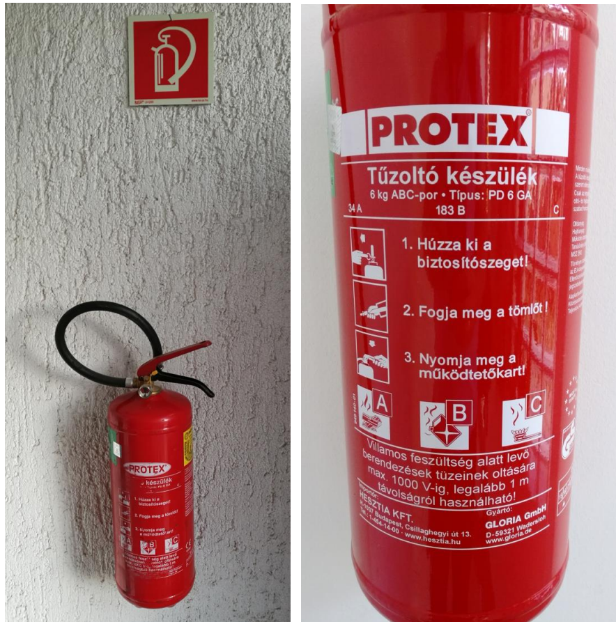
72. ábra Poroltó készülék a jelölő táblával és a kezelési utasítása
