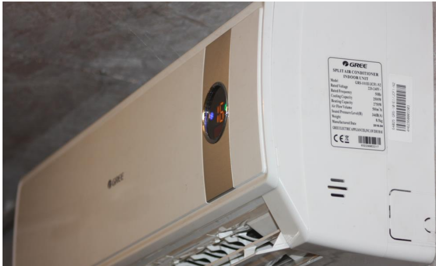
68. ábra Egy kisebb virágbolt 54 léghőméteres raktárhelyiségének hűtő berendezése
