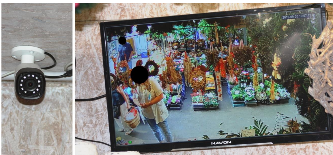
156. ábra Zárt láncú videórendszer, kamera és monitor egy virágboltban. Lopás esetén a felvétel visszajátszható, bizonyító értékű lehet.
