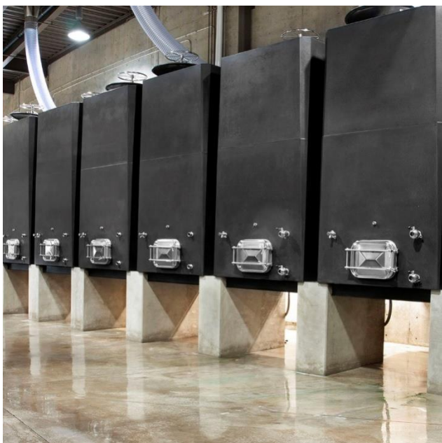
27. ábra Modern vasbeton tartályok 2
