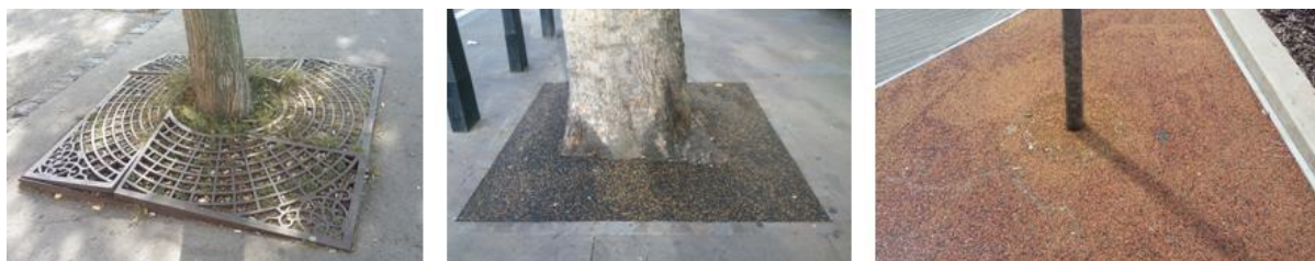
191. ábra A dísfák talajának védelme a tömörödéstől, taposástól: faveremráccsal (ami szintén igényelne karbantartást!), öntött, rugalmas burkolattal vagy öntött szemcsés, de szilárd burkolattal .
