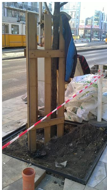
210. ábra A kaloda megvédi a fa törzsét a sérülésektől. Ha nagyobb kalodát építünk, az a teljes csurgót, a gyökérzetet is megóvhatja.
